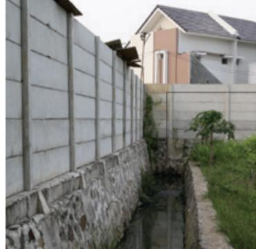
Penerapan Perimeter Ditch atau saluran tepi di luar kawasan untuk menjaga aliran luar tetap berjalan dengan baik
