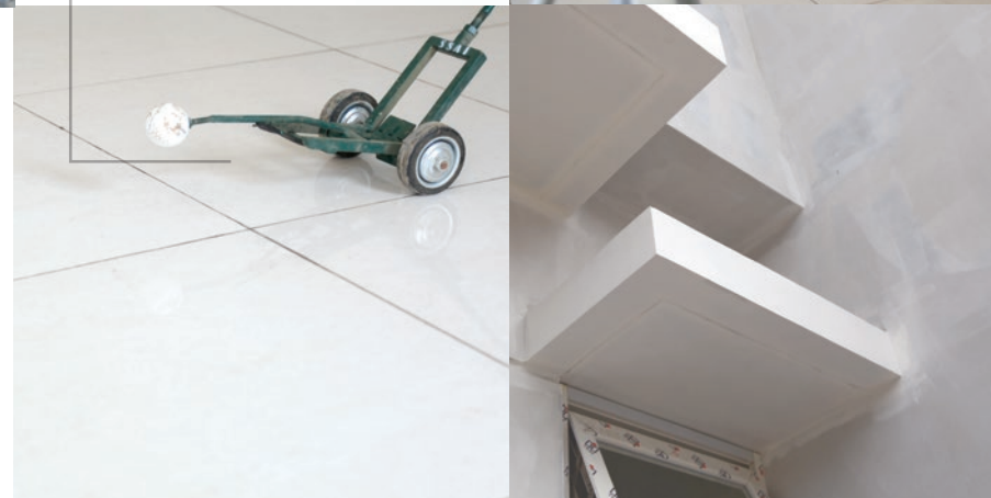
Teknik pemasangan dan pengecekan lantai keramik untuk menghindari kepadatan yang kopong.
