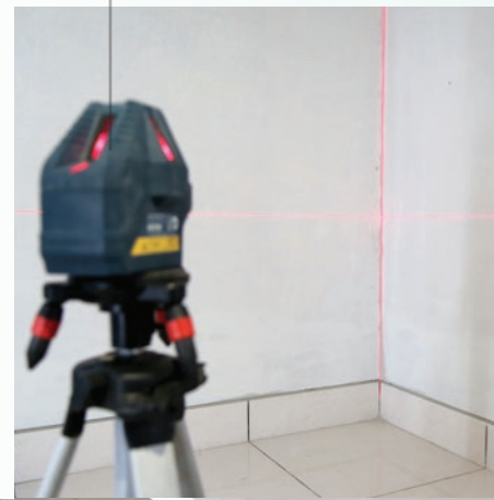
Pengecekan kualitas verticality dinding dengan laserline.
