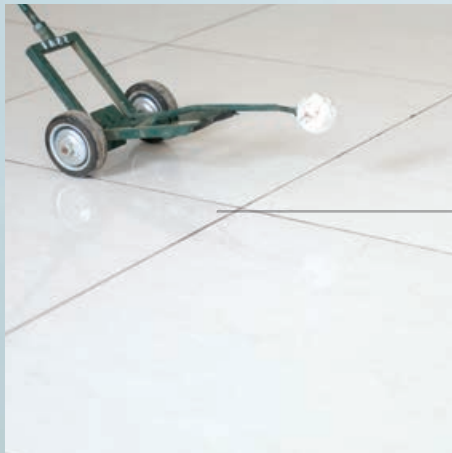
Teknik pemasangan dan pengecekan lantai keramik untuk menghindari kepadatan yang kopong.
