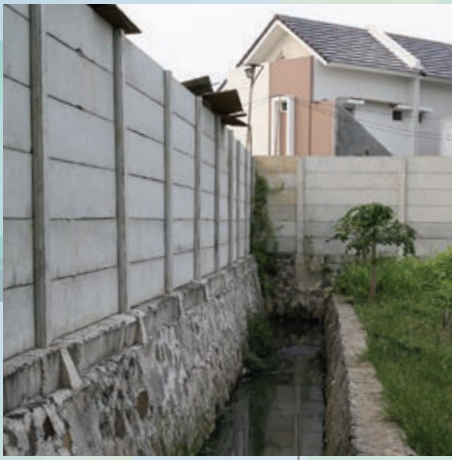
Penerapan Perimeter Ditch atau saluran tepi di luar kawasan.
