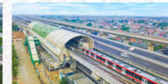
LRT STATION - BEKASI TIMUR
